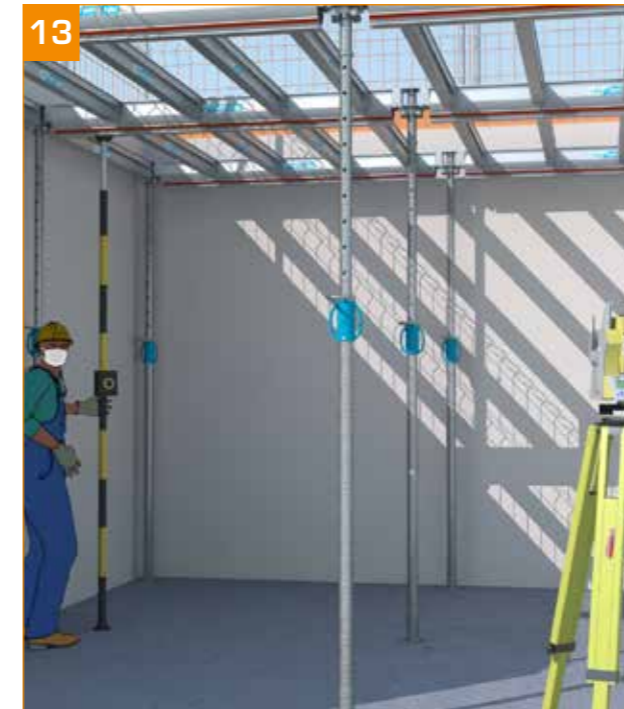
- Affiner la mise à niveau à l'aide d'un niveau laser ST par ST. - Une pince suspendue au coffrage permet à 1 seul homme d'effectuer le réglage au laser. Effectuer un dernier contrôle du verrouillage des têtes à cette étape.
