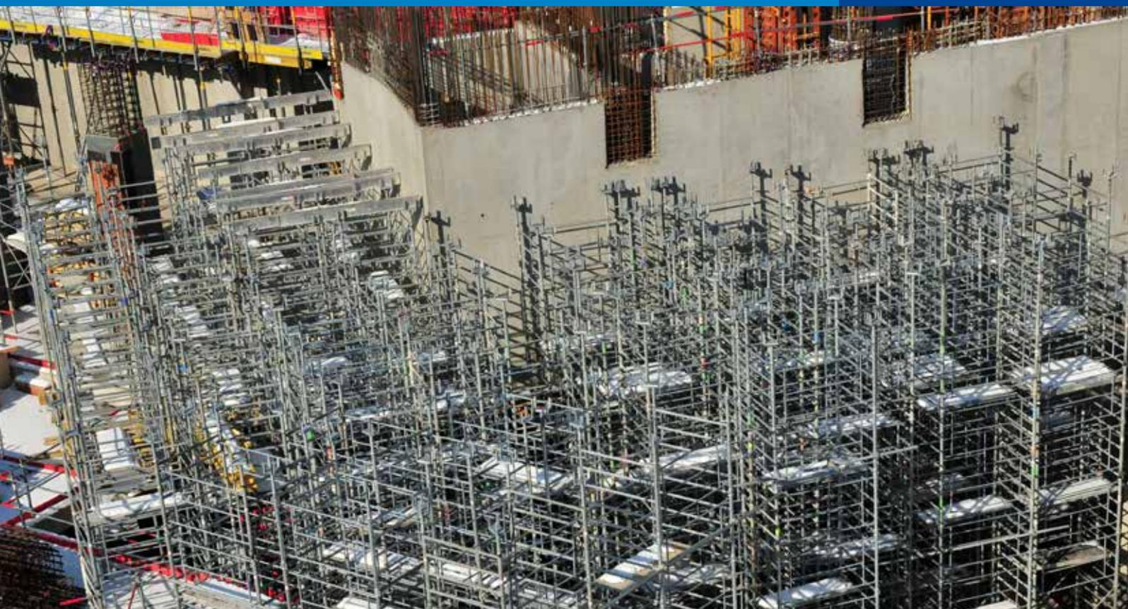
Bei dem Gerüstturm A120 handelt es sich um einen Leiterturm, der völlig sicher auf- und abgebaut werden kann. Seine hohe Stabilität ermöglicht eine Traglast von 3 t/Fuß.
