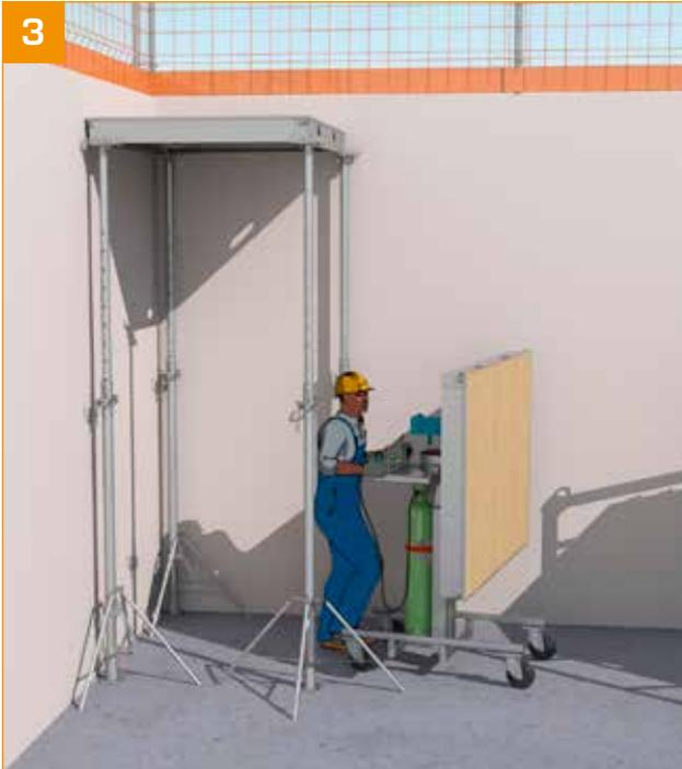
3 - Positionner le MaxUp à l'emplacement souhaité, l'opérateur se place sous le panneau déjà installé.
