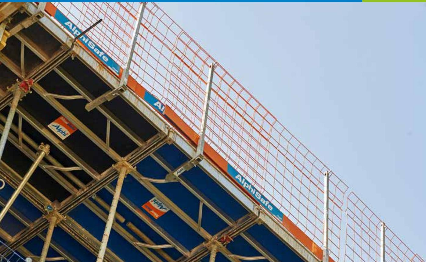
Le système de protection collective AlphiSafe se pose en sécurité depuis le bas. La grille est conçue avec deux plis renforçant sa rigidité. Une gamme complète d'adaptateurs permet de répondre à toutes les configurations de montage.
