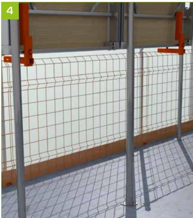
4 - Fixer au dos des panneaux, à leurs extrémités, 2 adaptateurs AlphiSafe pour MaxiDalle.
