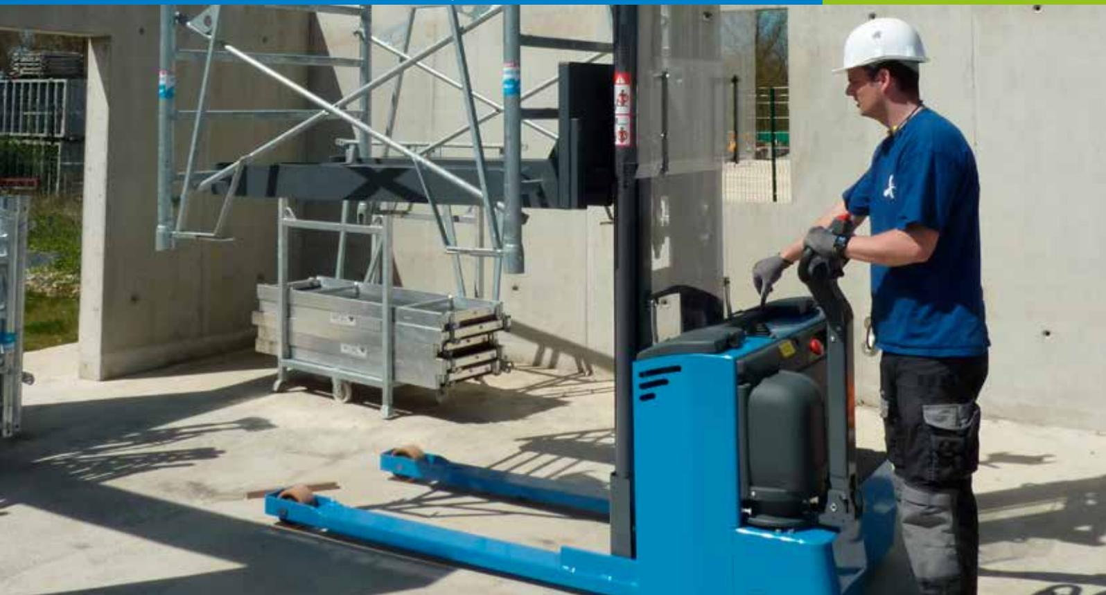
Le système Monte-Tour propose un montage des tours révolutionnaire, à l'inverse du montage traditionnel. Les chutes de hauteur et d'objets sont ainsi supprimées.
