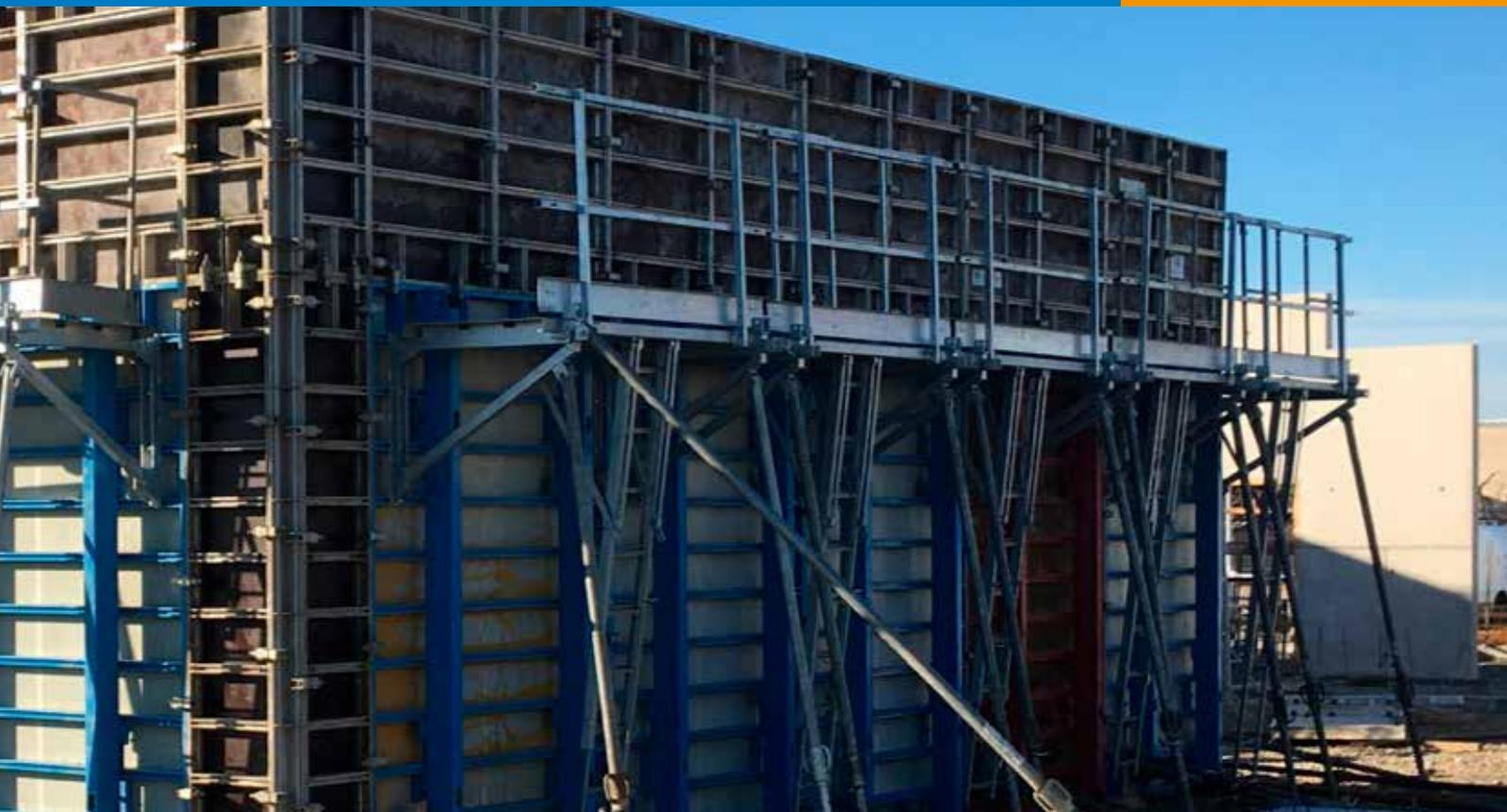
Les panneaux de coffrage VerticAL en aluminium, modulaires et robustes, permettent toutes les combinaisons géométriques.
