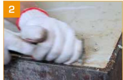
2 - Les zones endommagées sont préparées pour être réparées en enlevant les salissures et les résidus d'huile de coffrage avec un grattoir à peinture.
