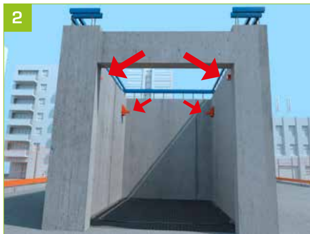
2 - Les claps sont insérés dans les réservations depuis l'intérieur de la cage.
