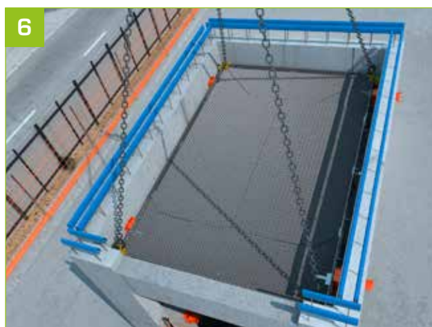
6 - Les claps se replient au passage du Podium.
