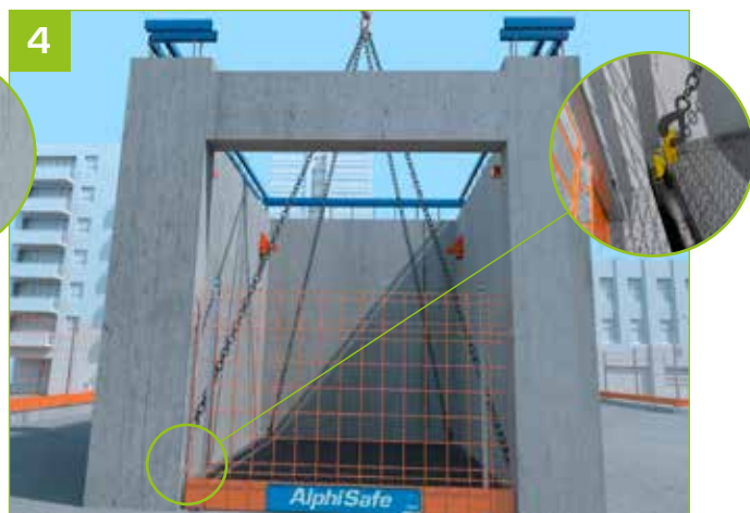
4 - Le Podium est soulevé à la grue. - Les tôles latérales se relèvent automatiquement.
