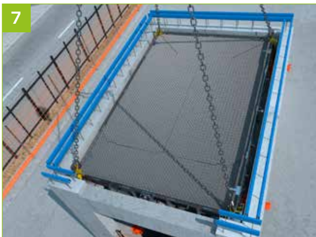
- Les claps se déplient automatiquement et le Podium passe au-dessus.
