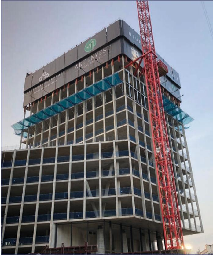
Grâce à son porte-à-faux de 3 m, le filet de protection crée devant le bâtiment une zone de protection contre les chutes de matériaux, d'outils ou de gravats. En outre, il est destiné à amortir les chutes des personnels de chantier et permet de les secourir.
